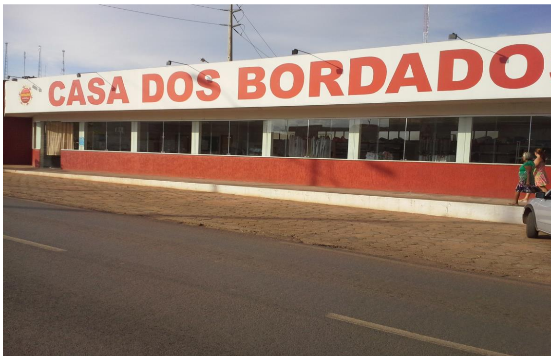
Figura 4 - Fachada da Associação Casa dos Bordados
