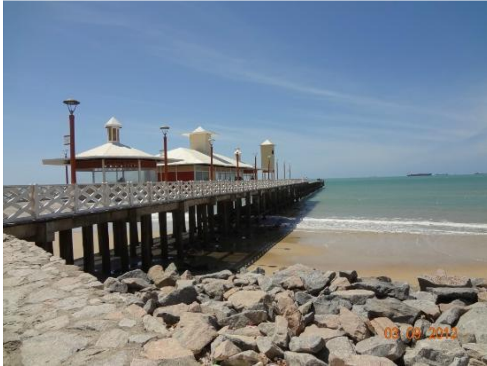
Figura 15 – Ponte dos Ingleses
