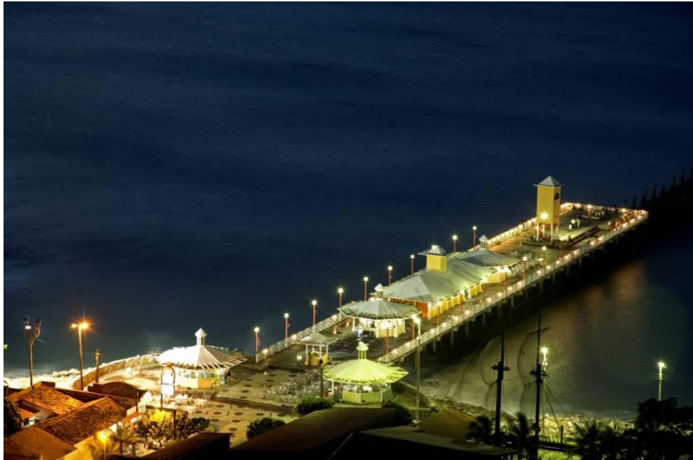
Figura 16 – Vista aérea da Ponte dos Ingleses
