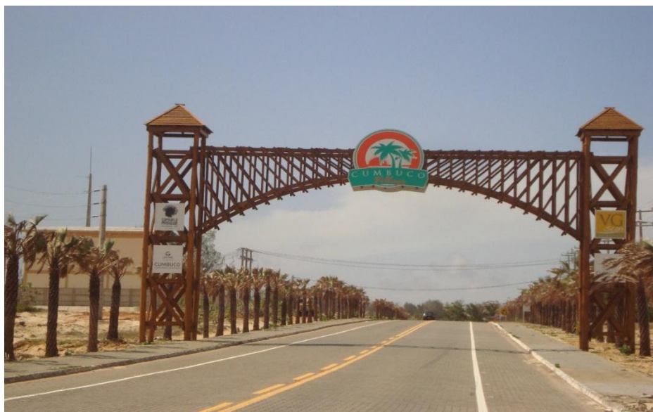
Figura 28 – Via de acesso que leva ao Resort Vila Galé e Vg Sun
