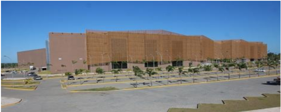
Figura 1 – Fachada do Centro de Eventos do Ceará
