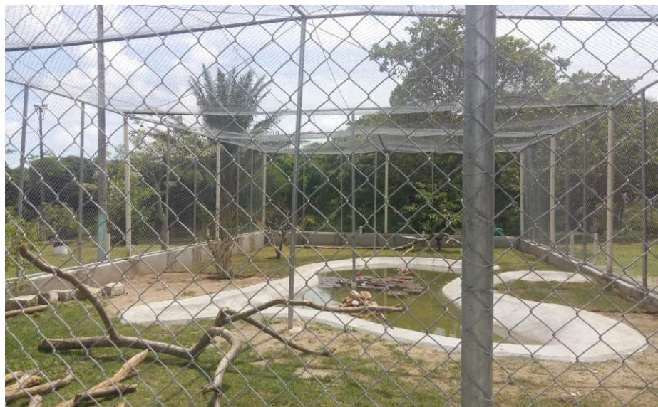
Figura 21 – Recintos que estão sendo construídos para abrigar novos animais que estão para chegar
