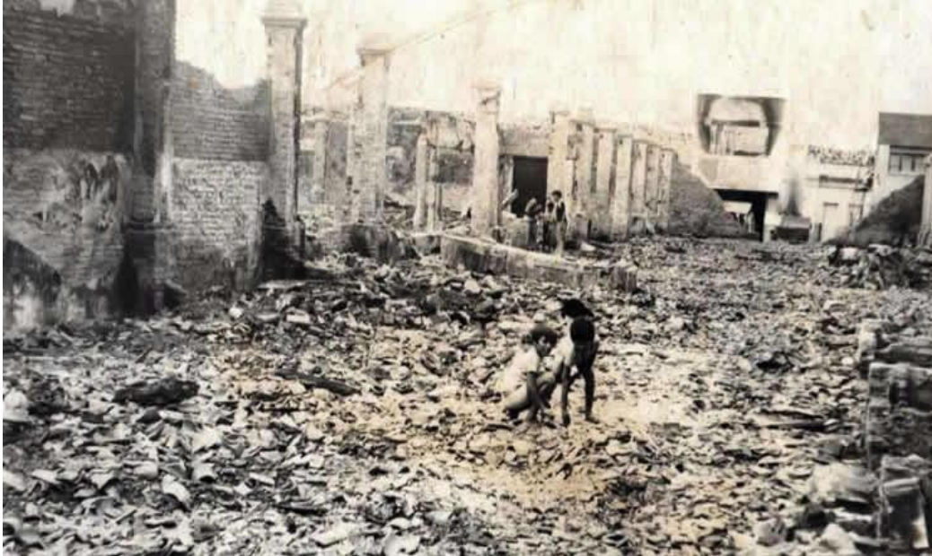
Figura 29 – Incêndio nas lojas centrais de Juazeiro do Norte
