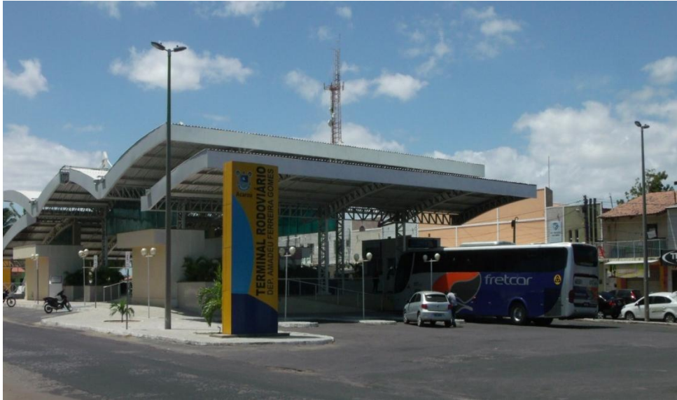
Figura 26 – Terminal Rodoviário de Acaraú
