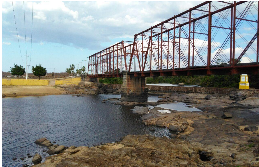
Figura 18 – Ponte metálica sobre o Rio Coreaú no município de Granja
