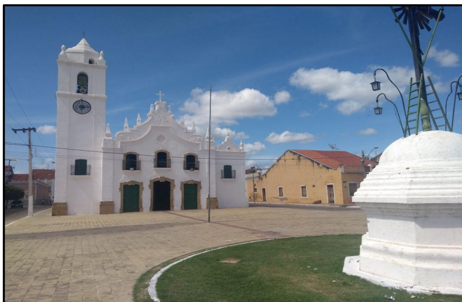
Figura 3 – Igreja de Nossa Senhora da Expectação
