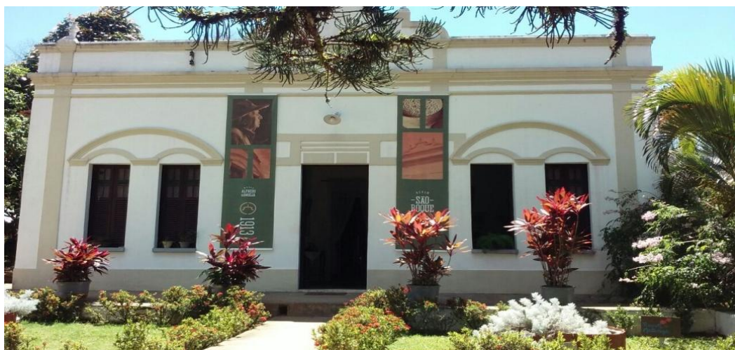
Figura 24 – Fachada do Sítio São Roque em Mulungu
