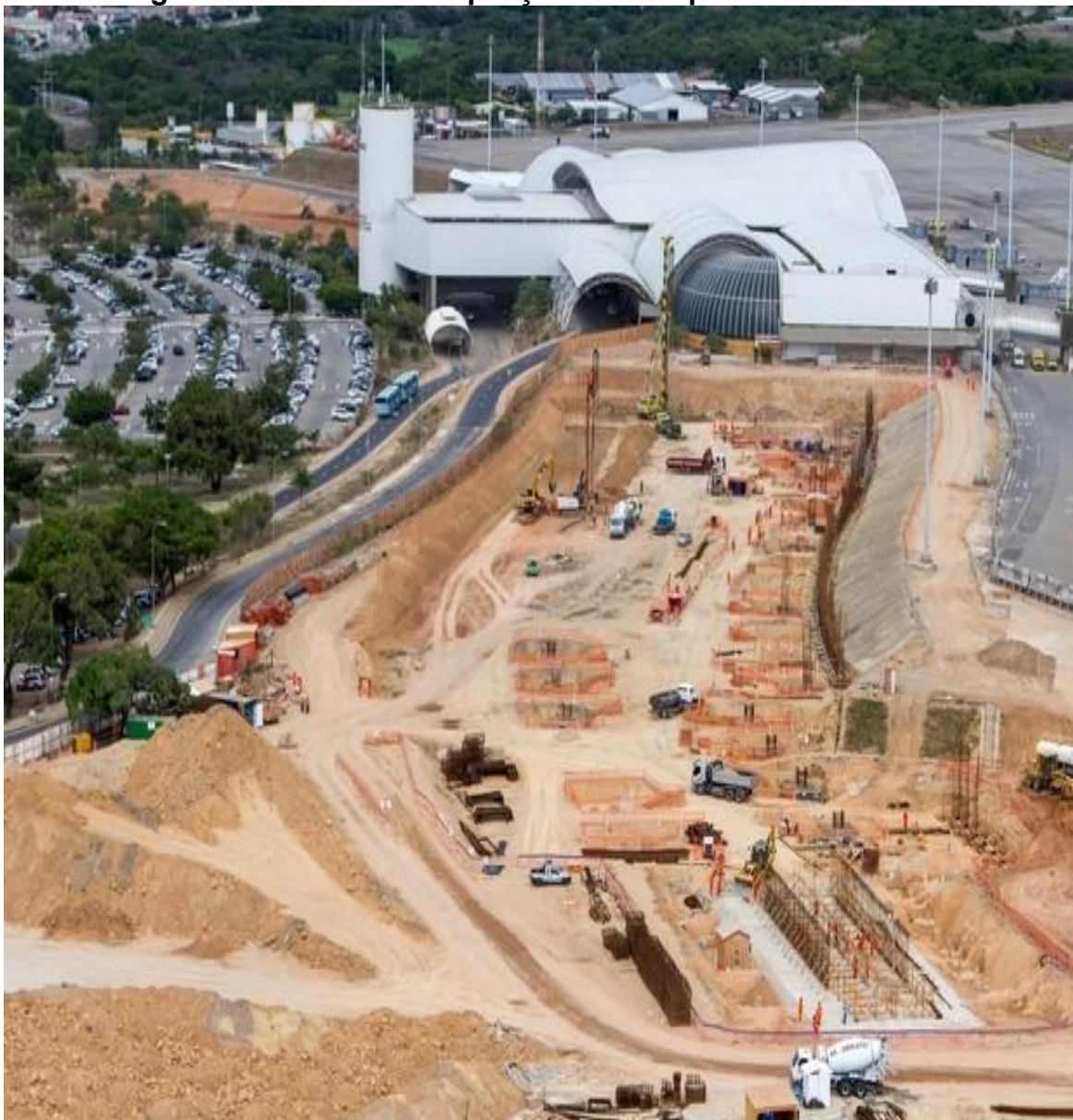
Figura 10 – Obras de ampliação do Aeroporto Pinto Martins
