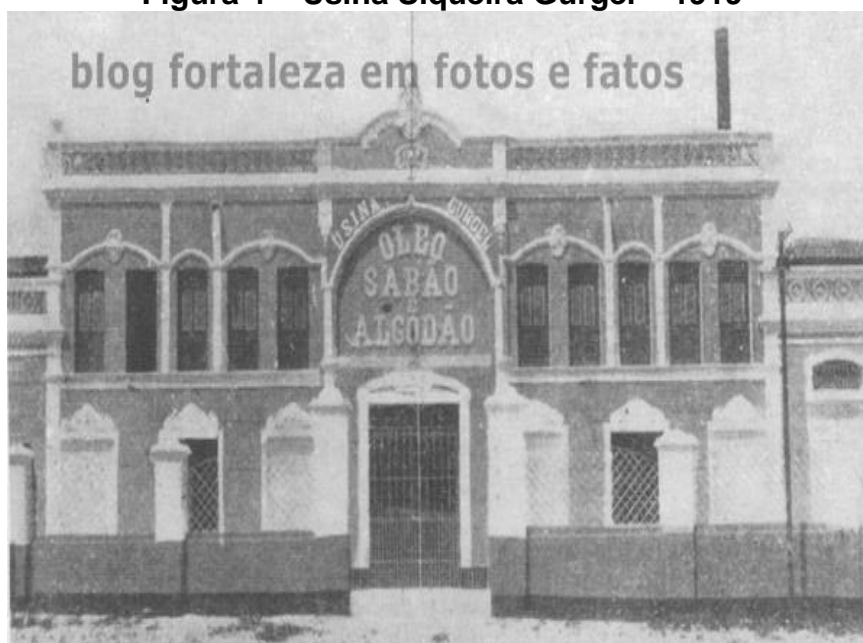
Figura 4 – Usina Siqueira Gurgel – 1919
