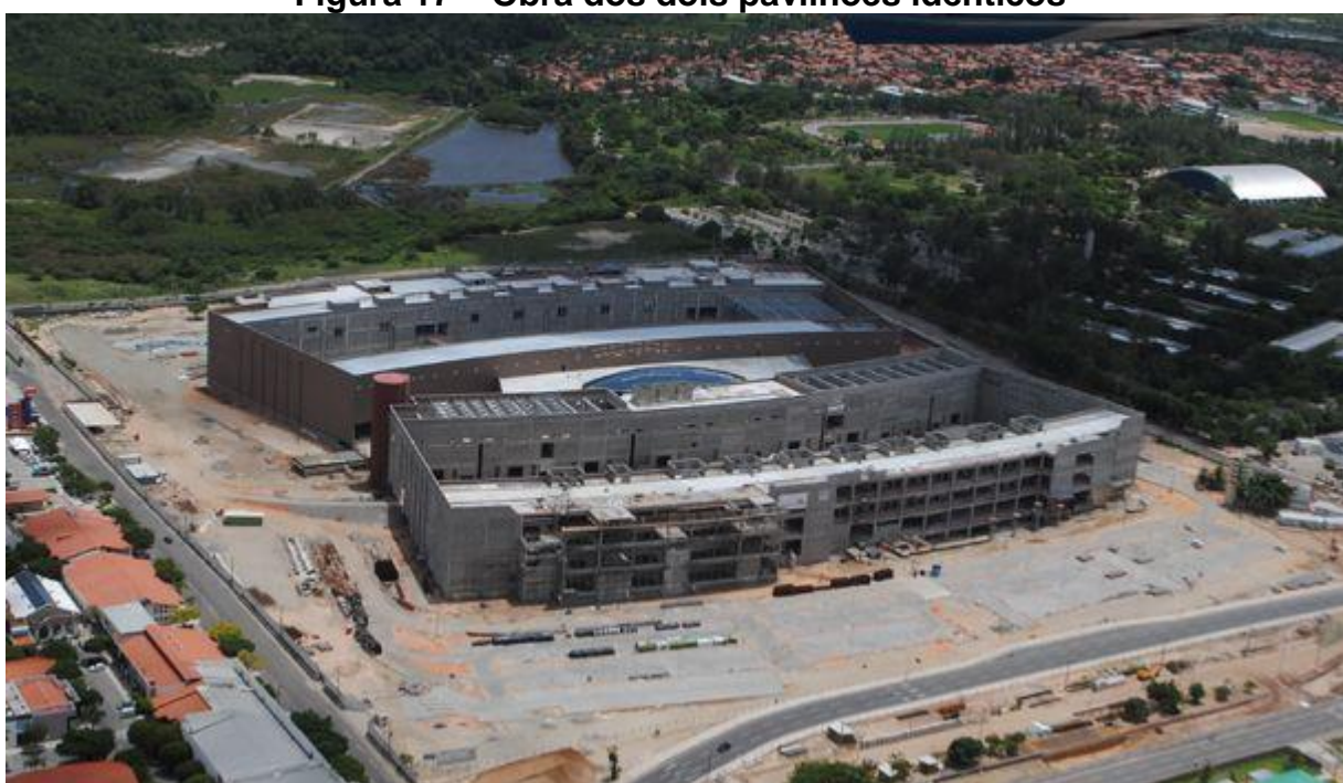
Figura 17 – Obra dos dois pavilhões idênticos
