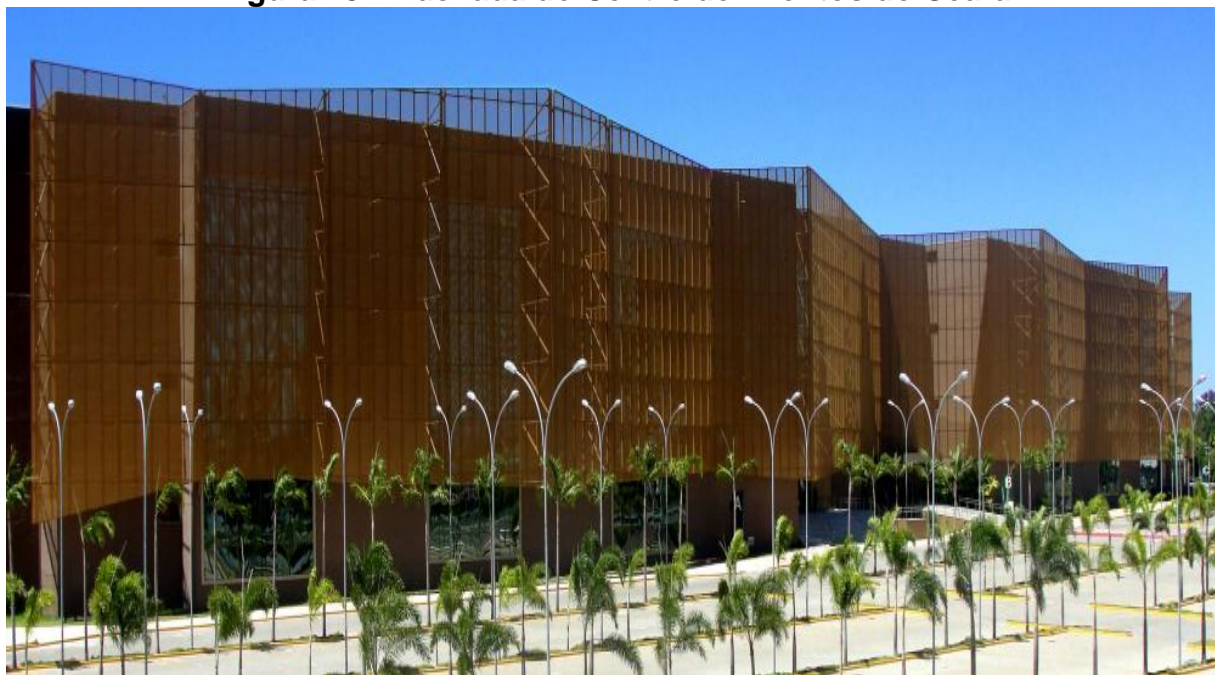
Figura 18 – Fachada do Centro de Eventos do Ceará
