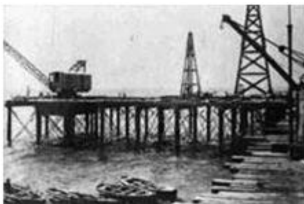
Figura 5 – Construção da Ponte Metálica
