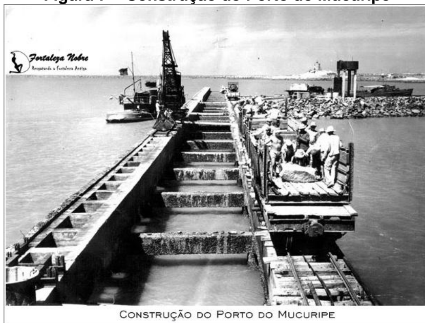
Figura 7 – Construção do Porto do Mucuripe
