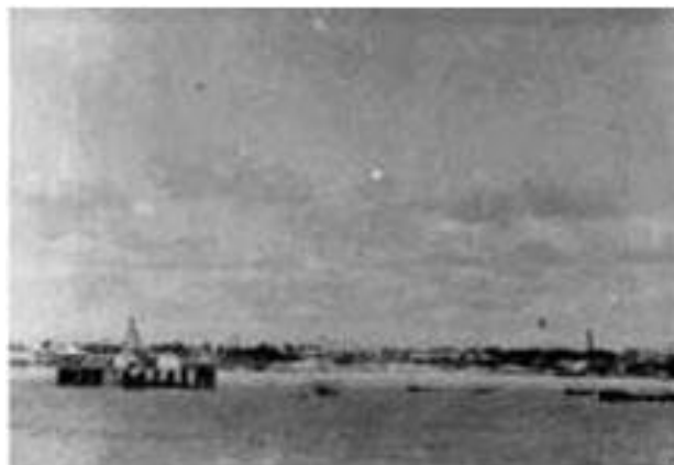
Figura 6 – Outra visão da Ponte Metálica
