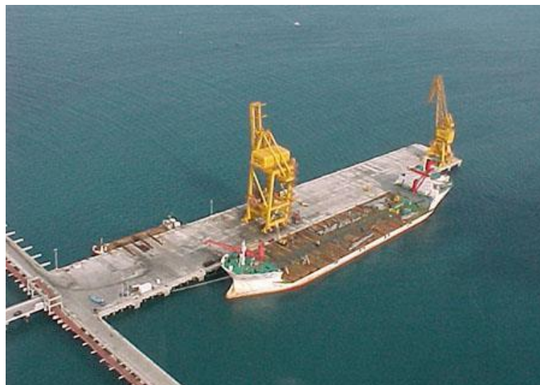
Figura 9 – Ponta do Pecém – Instalação do Canteiro de obras (1996)
