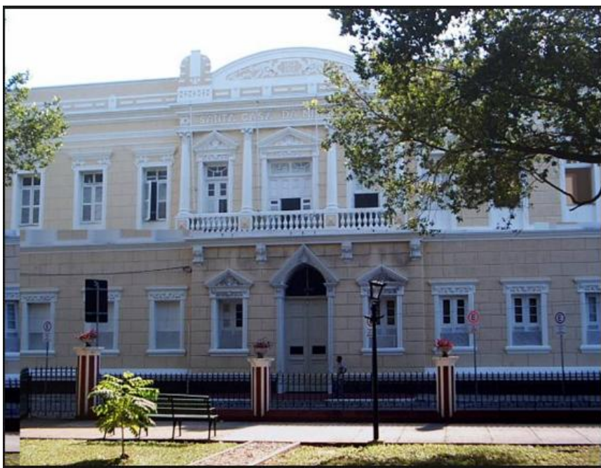
Figura 5 – Santa casa de misericórdia atual
