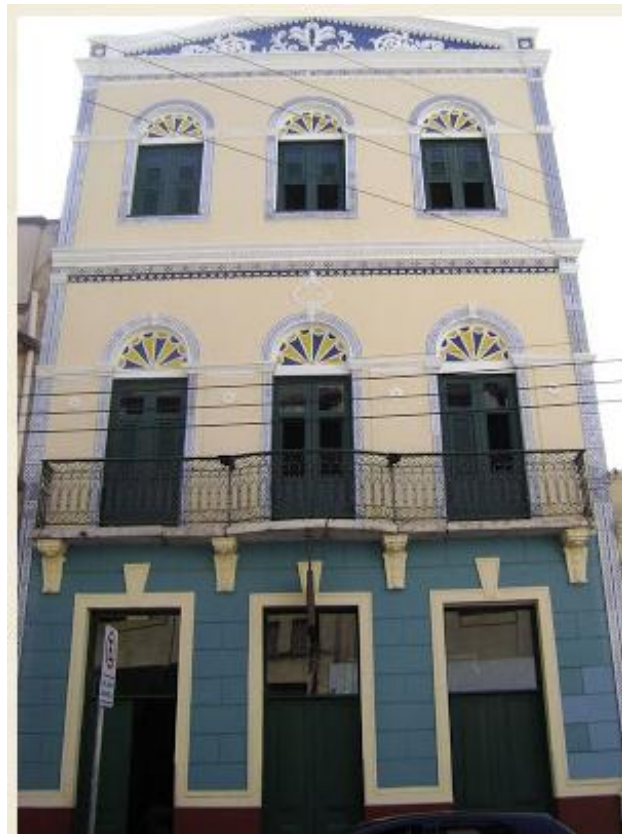
Figura 11 – Sobrado do Dr. José Lourenço após a restauração
