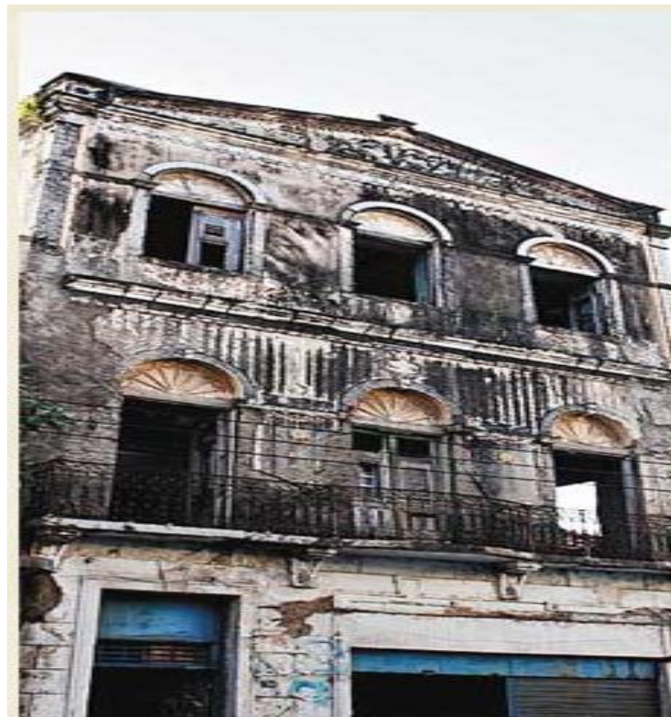
Figura 12 – Sobrado do Dr. José Lourenço antes da restauração
