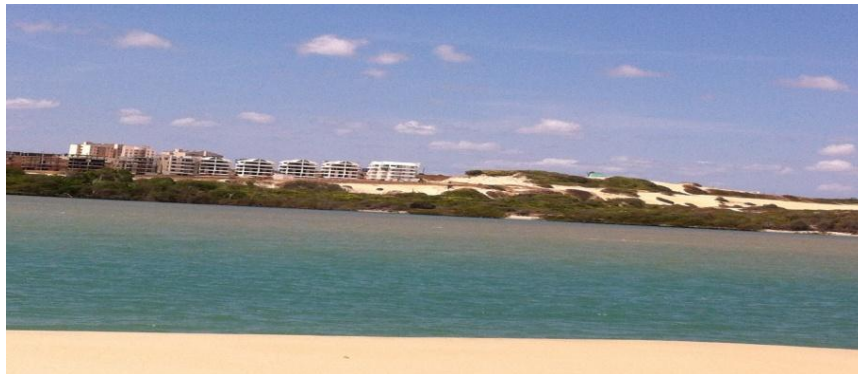
Figura 15 - Construção irregular em área preservada: foz do rio Pacoti
