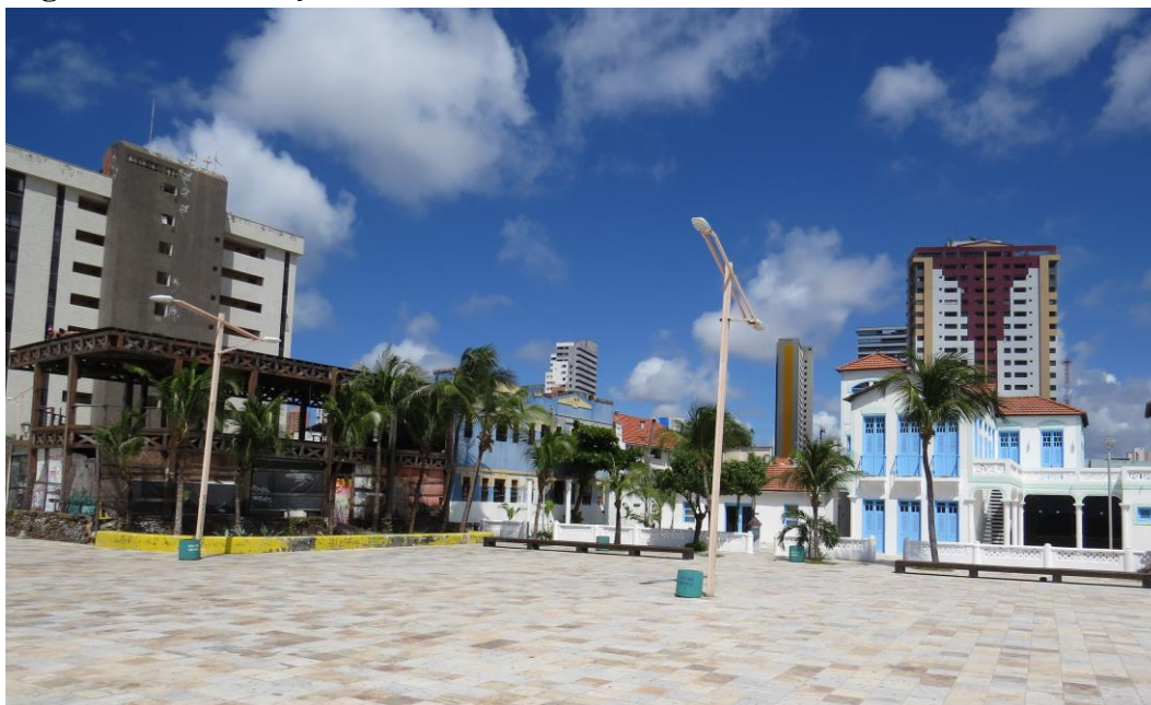
Figura 39 – Instalações abandonadas do restaurante Sobre o Mar D'Iracema
