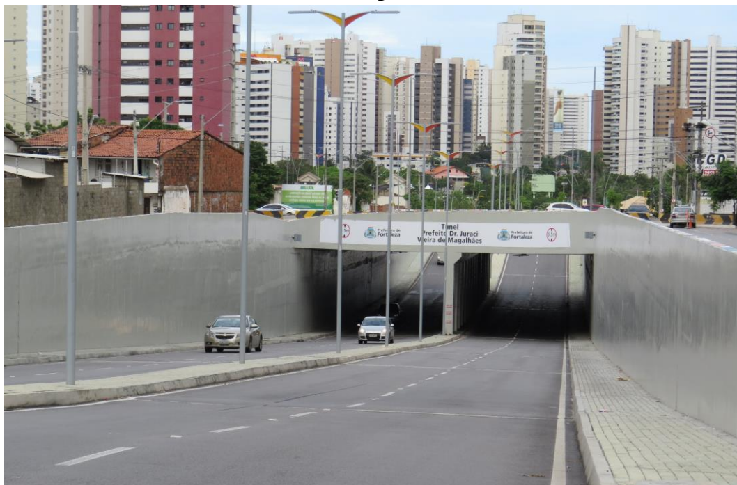
Figura 22 – Túnel no cruzamento da Via Expressa com Avenida Padre Antônio Tomás
