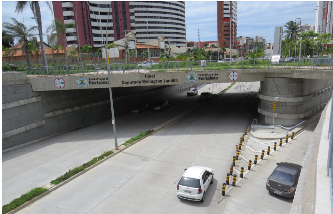
Figura 20 – Túnel no cruzamento das avenidas Engenheiro Santana Júnior e Pe. Antônio Tomás
