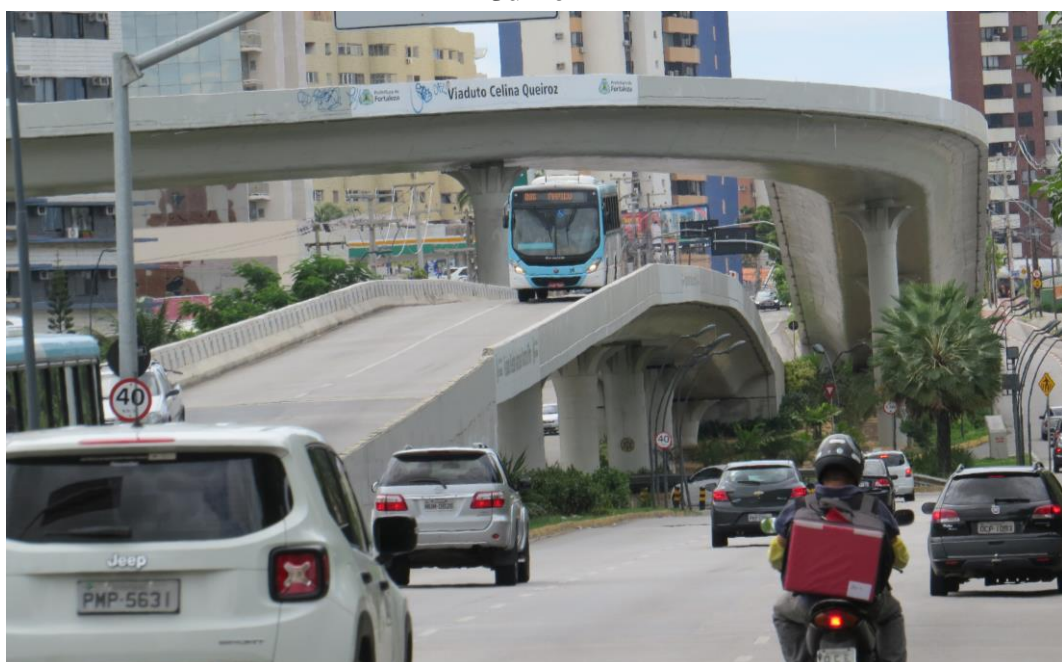
Figura 19 – Viadutos no cruzamento das avenidas Antônio Sales e Engenheiro Santana Júnior
