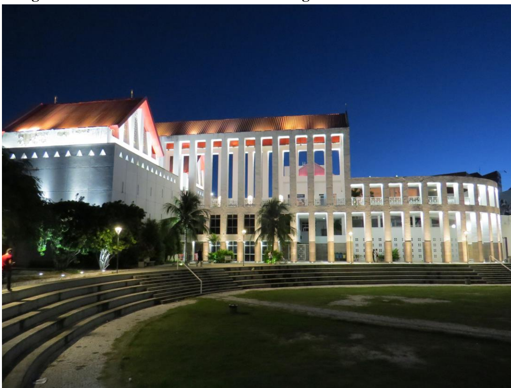
Figura 48 – Fachada lateral do Centro Dragão do Mar de Arte e Cultura
