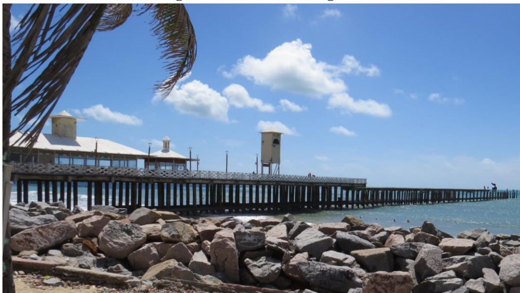
Figura 80 – Ponte dos Ingleses
