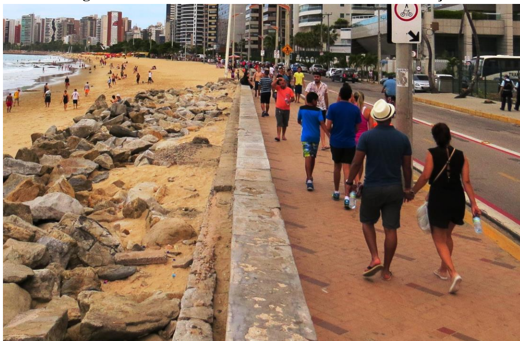
Figura 42 – Bancos da Praia do Meireles sem manutenção
