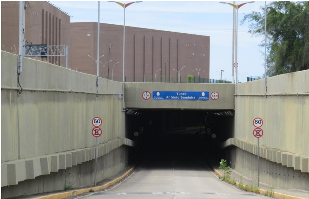
Figura 24 – Túnel Antônio Bandeira
