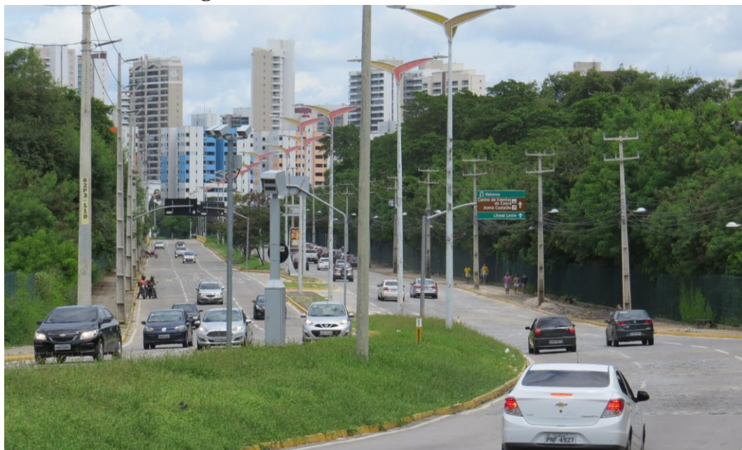
Figura 25 – Avenida Sebastião de Abreu
