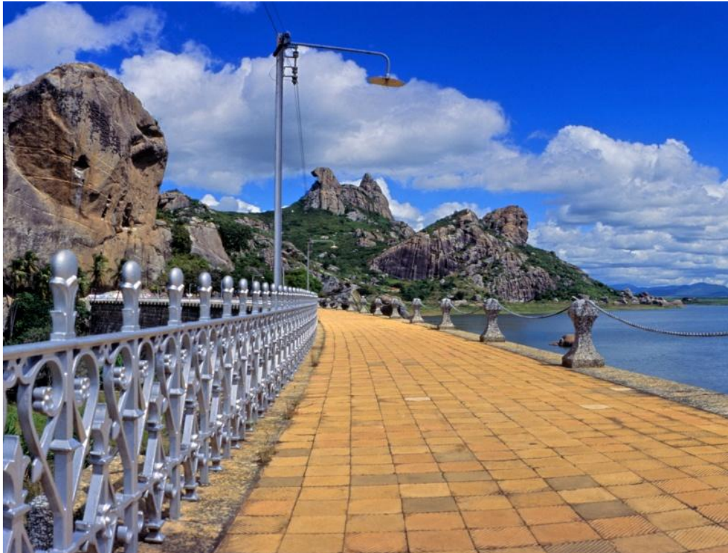
Figura 34 - Pedra da Galinha Choca vista da barragem do Açude do Cedro 53
