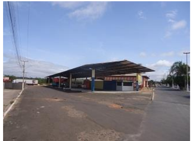
Foto 8 – Rodoviária de Tianguá
