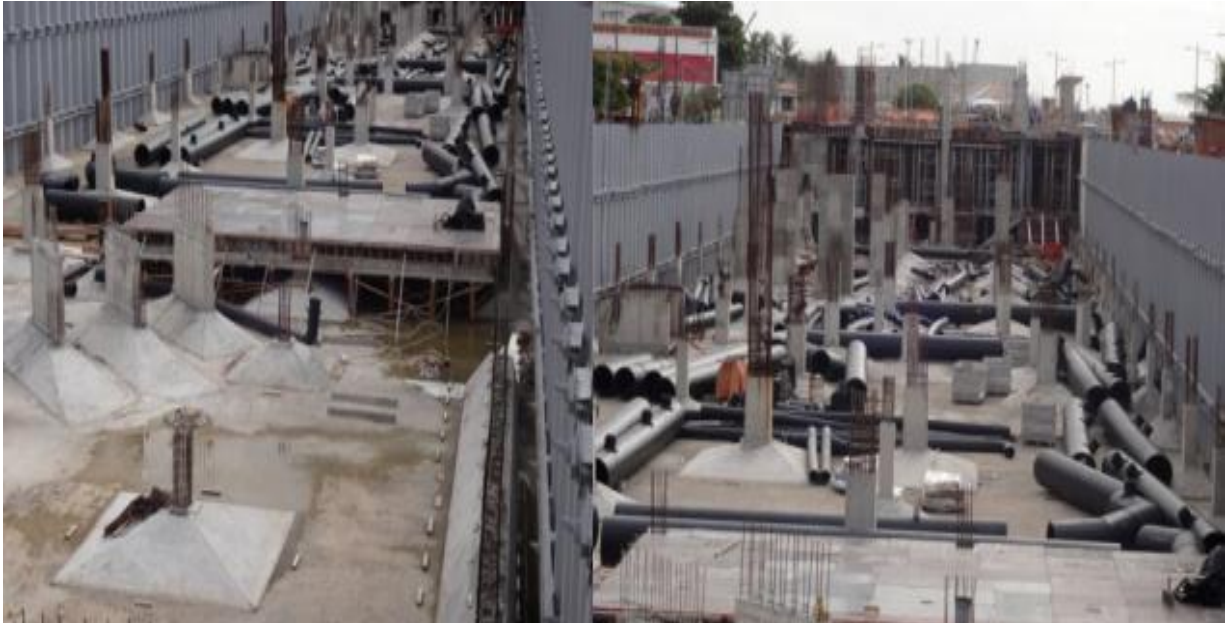
Figura 5 – Estrutura interna do Acquário Ceará
