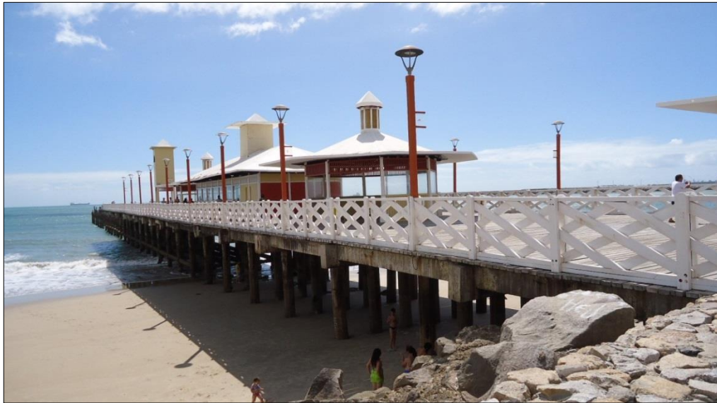
Figura 8: Ponte dos Ingleses (Ponte Metálica) – Praia de Iracema.
