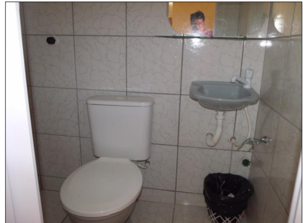
Figura 33: Banheiro da Pousada Palmatur.
