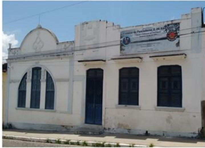
Figura 16 – Casa de Tavares Bastos
