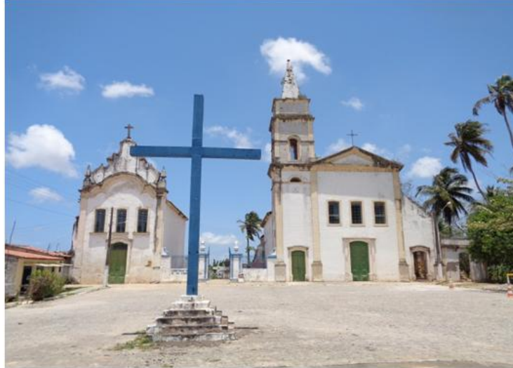
Figura 17 – Conjunto Conventual do Carmo (Igreja e Convento)
