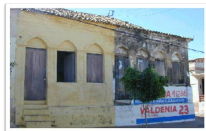
Figura 31 - 15- Rua T. Filgueiras, nº 276
