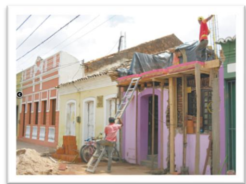
Figura 22 - Rua da Matriz, nº 14/18, descaracterizado
