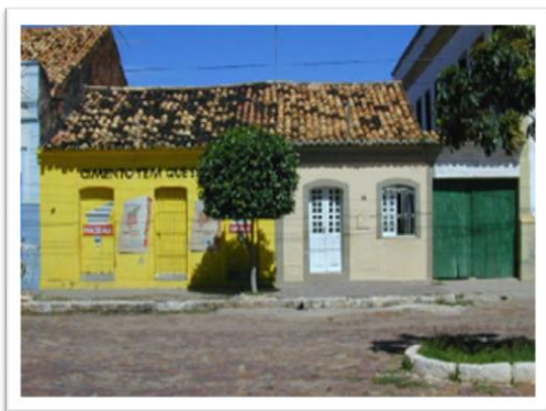
Figura 21 - Rua da Matriz, nº 14/18, antes da descaracterização
