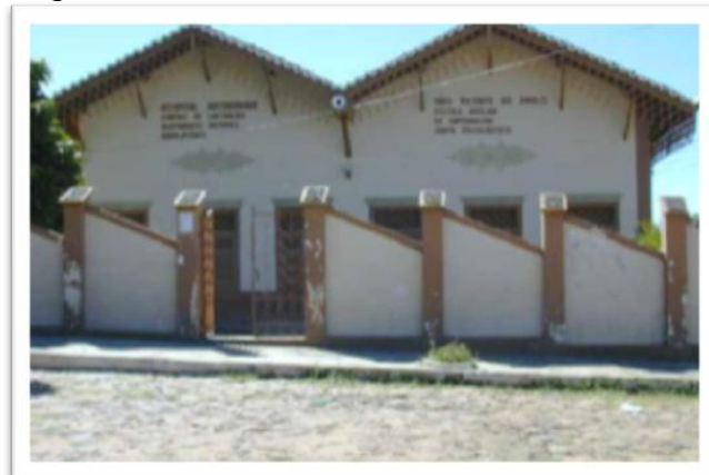
Figura 14 - Chalé da Rua dos Salvatorianos
