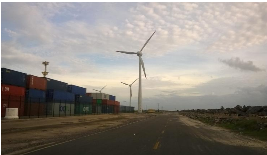
Figura 20 – Pátio de contêineres
