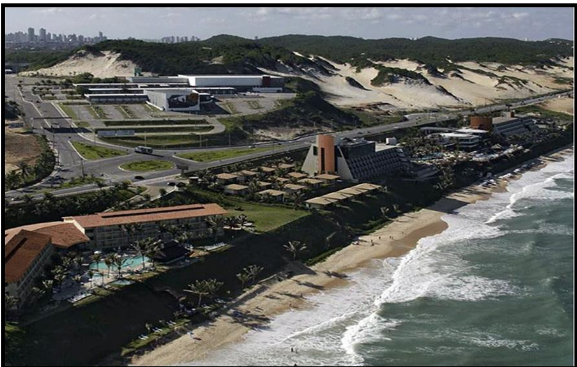
Figura 3: Equipamentos hoteleiros localizados na Via Costeira
