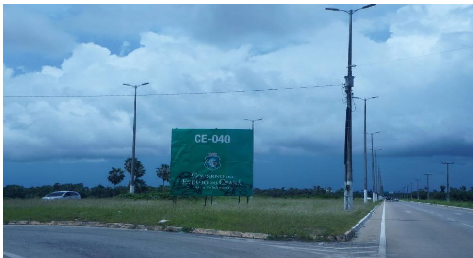
Figura 16: Rodovia Estadual, CE – 040, que liga Fortaleza a Aquiraz-CE, Brasil.
