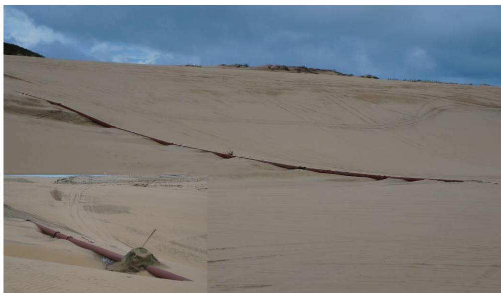
Figura 52: Tubulações de esgoto implantadas pelo complexo turístico Aquiraz Riviera no corpo dunar na Prainha em Aquiraz-CE, Brasil.
