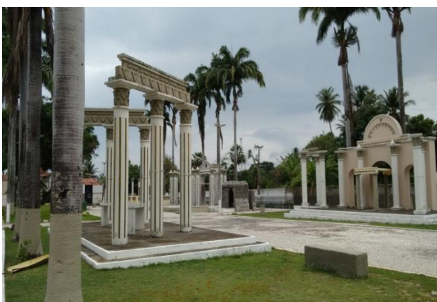
Figura 30 - Estrutura fixa, onde é realizado o espetáculo Paixão de Cristo, Pacatuba – CE
