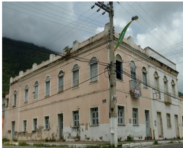
Figura 39 - Sobrado dos Cavalcante. Pacatuba – CE
