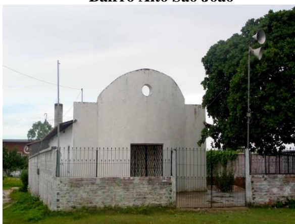
Figura 24 - Capela São João Batista no Bairro Alto São João
