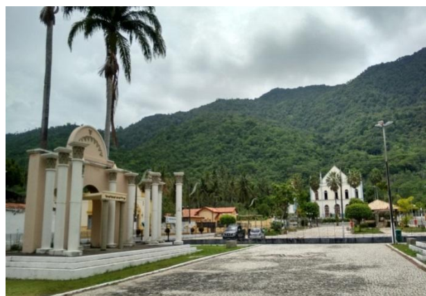
Figura 31 -- Estrutura fixa, onde é realizado o espetáculo Paixão de Cristo, Pacatuba – CE
