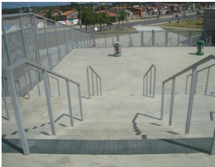
Figura 43 – Foto do corrimão da Arena Castelão Fonte: pesquisa de campo, 2013. Fotógrafo: Ícaro C. Honório.
