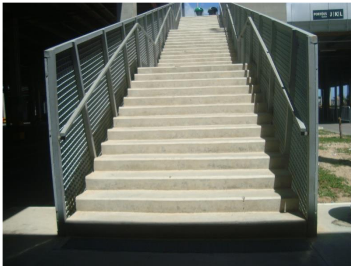
Figura 42 – Foto do corrimão da Arena Castelão Fonte: pesquisa de campo, 2013. Fotógrafo: Ícaro C. Honório.
