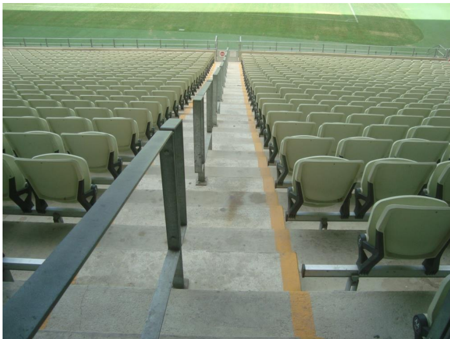
Figura 30 – Foto da escada da Arena Castelão Fonte: pesquisa de campo, 2013. Fotógrafo: Ícaro C. Honório.
