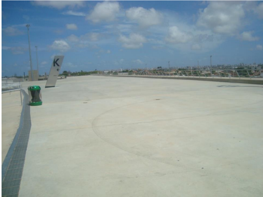
Figura 20 – Foto da circulação externa da Arena Castelão Fonte: pesquisa de campo, 2013. Fotógrafo: Ícaro C. Honório.
