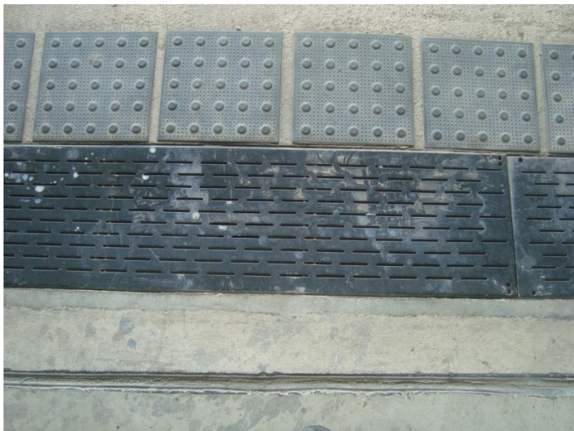
Figura 18 – Foto do coletor da Arena Castelão Fonte: pesquisa de campo, 2013. Fotógrafo: Ícaro C. Honório.
