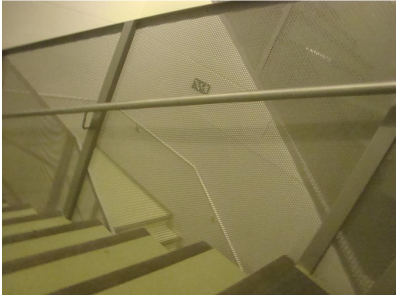
Figura 28 – Foto da escada da Arena Castelão Fonte: pesquisa de campo, 2013. Fotógrafo: Ícaro C. Honório.
