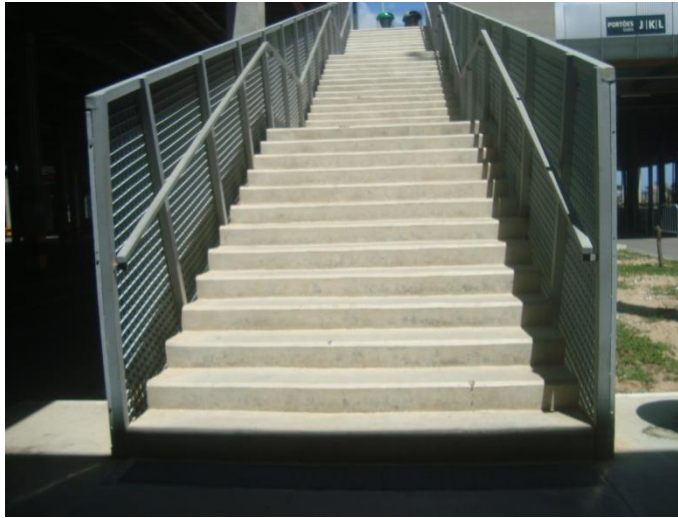
Figura 31 – Foto da escada da Arena Castelão Fonte: pesquisa de campo, 2013. Fotógrafo: Ícaro C. Honório.
