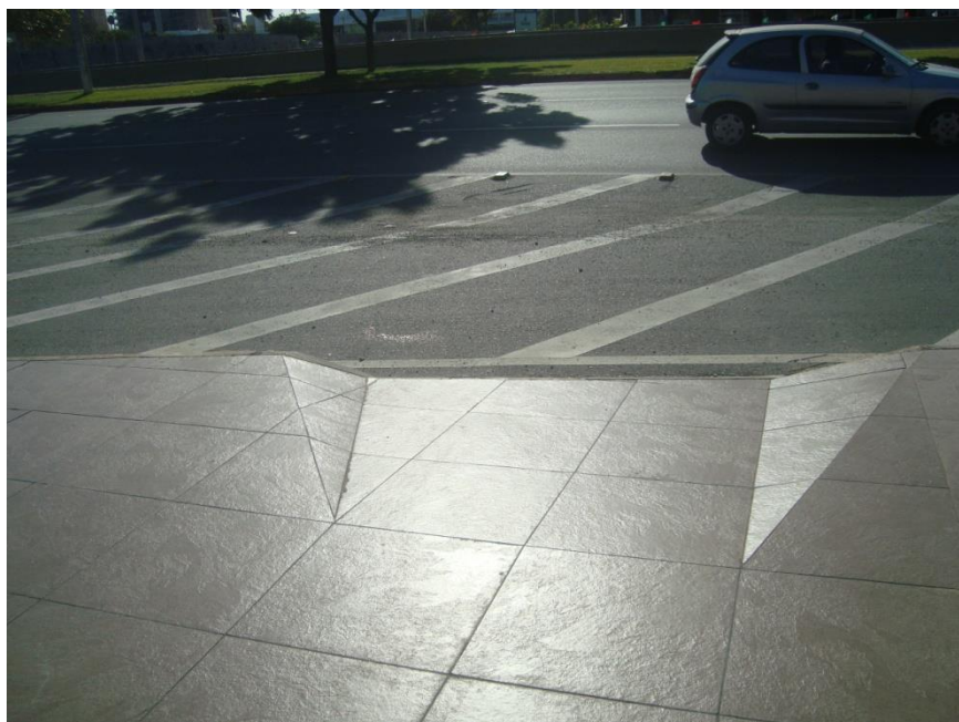
Figura 92 – Foto do rebaixamento de calçada do Centro de Eventos Fonte: pesquisa de campo, 2013. Fotógrafo: Ícaro C. Honório.
