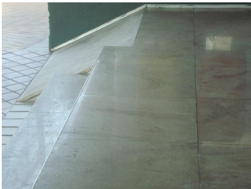
Figura 65 – Foto da rampa do Hotel X Fonte: pesquisa de campo, 2013. Fotógrafo: Ícaro C. Honório.
