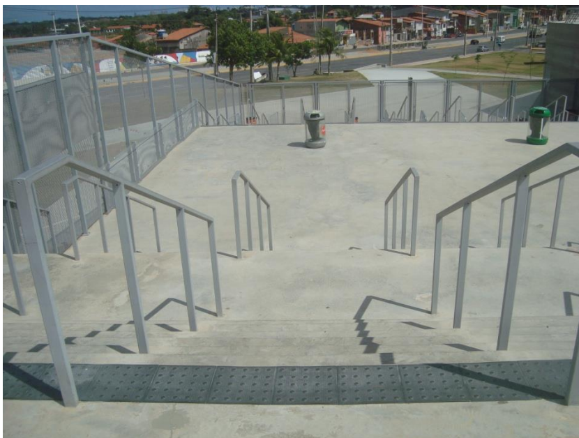
Figura 29 – Foto da escada da Arena Castelão Fonte: pesquisa de campo, 2013. Fotógrafo: Ícaro C. Honório.
