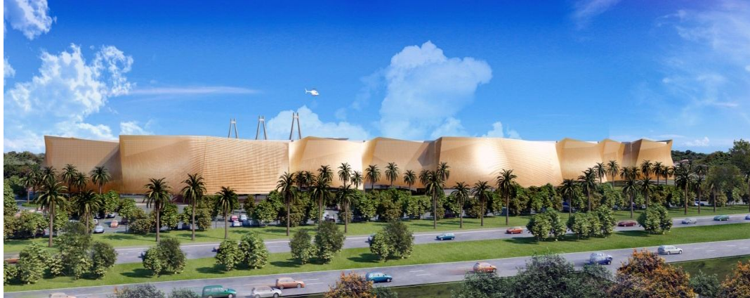
Figura 23 – Fachada do CEC no Projeto Inicial
