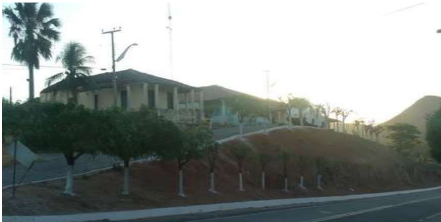
Figura 2 – Fotografia das Casas do DNOCS (atual)
