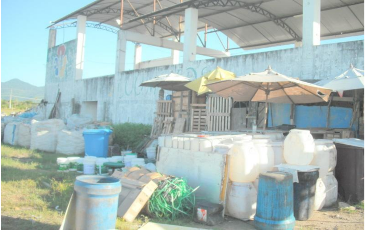
Figura 7 – Fachada da cooperativa com cobertas adaptadas para guardar o material
