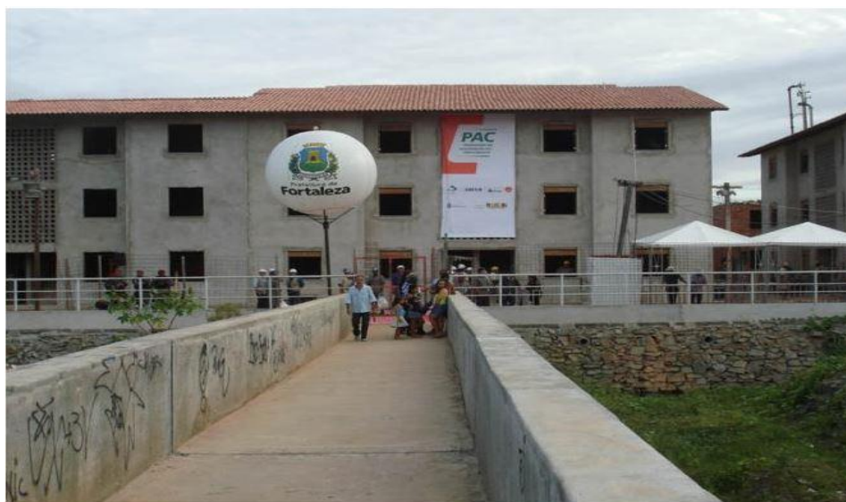
Vista da fachada de um dos prédios do Conjunto Habitacional Maravilha (Prefeitura Municipal de Fortaleza, 2006).
