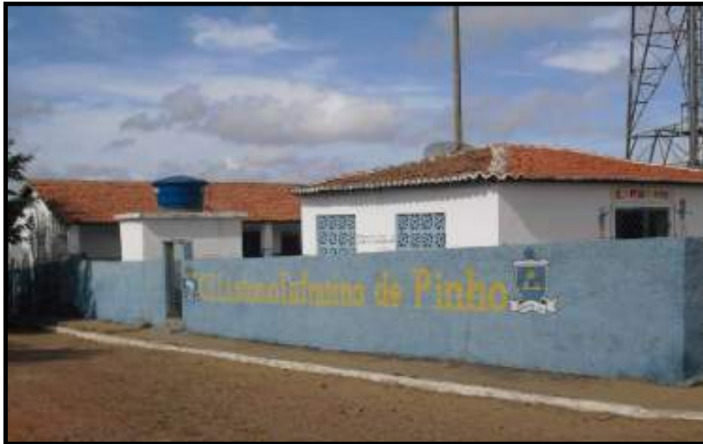
FIGURA 7 - Imagem da fachada da Creche onde funcionam salas de aula da EEEFRL
