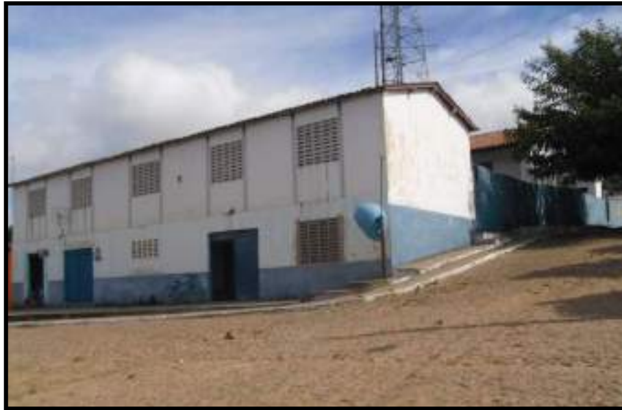
FIGURA 9 - Fotografia do espaço externo das salas onde funcionavam a Sala de aula A, sob a laje, no turno da manhã, e a Sala de aula B sobre ela, no período da tarde.
