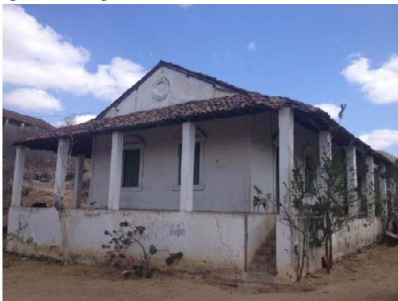
Figura 12 - Casa dos Engenheiros.
