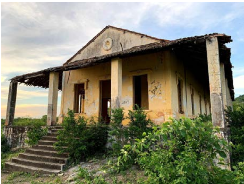
Figura 13 - Casarão da Inspetoria.
