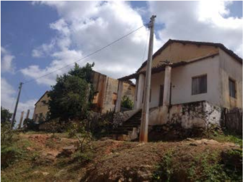
Figura 9 - Casa dos Apontadores.
