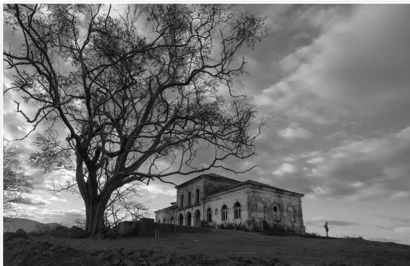
Figura 1 – Casarão abandonado em Guaiúba-CE
