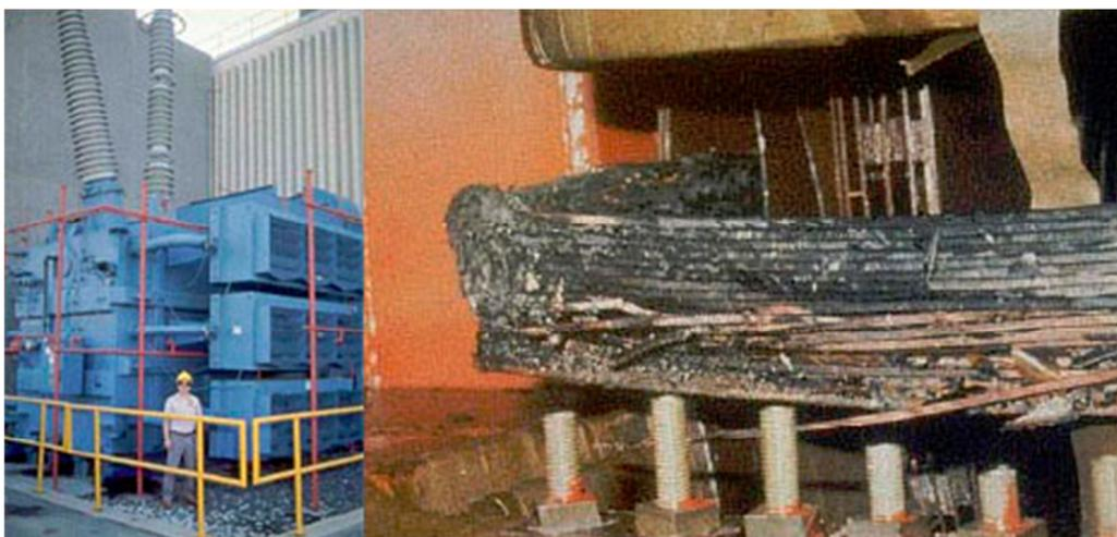
Figura 20: Transformador danificado por uma tempestade magnética em Quebec, Canadá. (Fonte: <http://bussoladeplasma.wordpress.com>)
