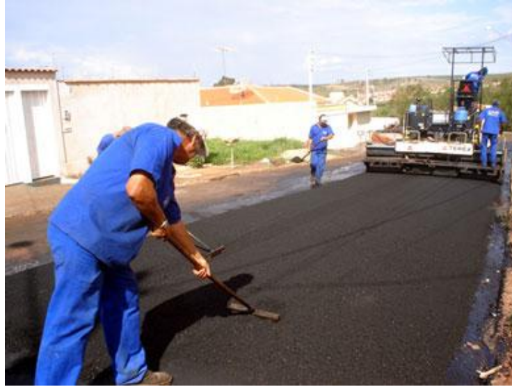
Figura 8- Cobertura de asfalto sendo colocada no solo. Fonte: INFOESCOLA, 2011.
