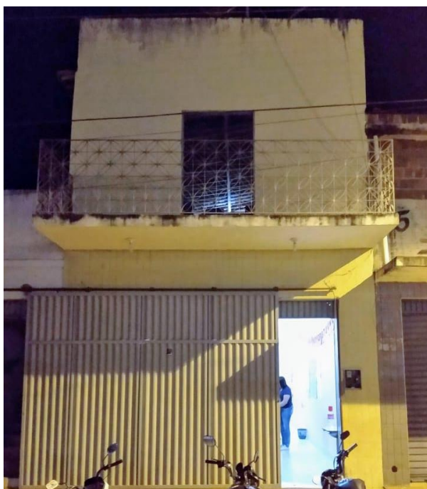
Figura 10 – Fachada do prédio improvisado da extensão de Guia
