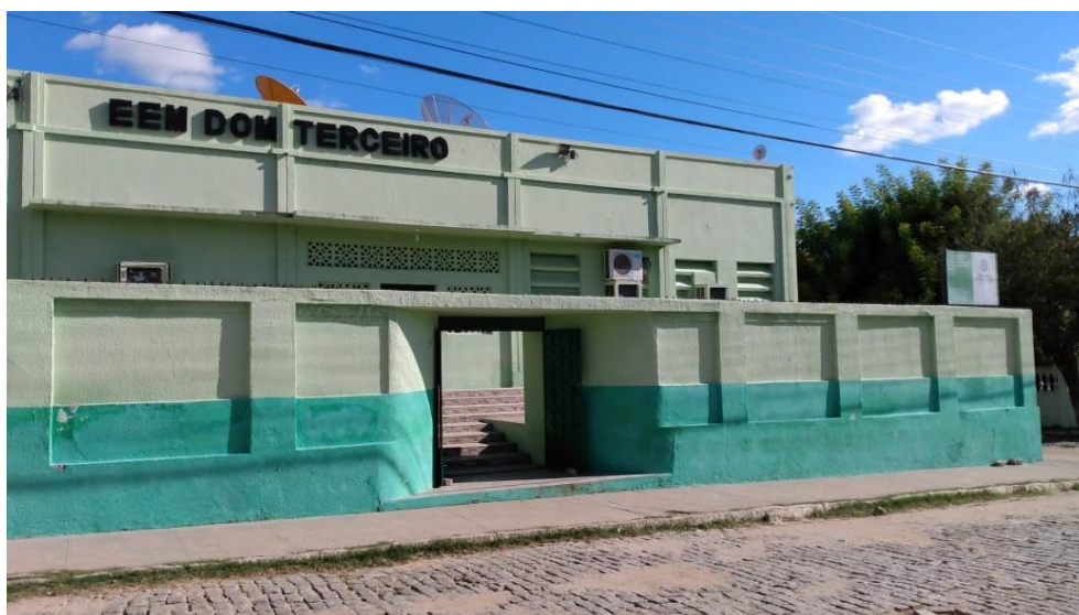
Figura 8 – Fachada da EEM de Dom Terceiro
