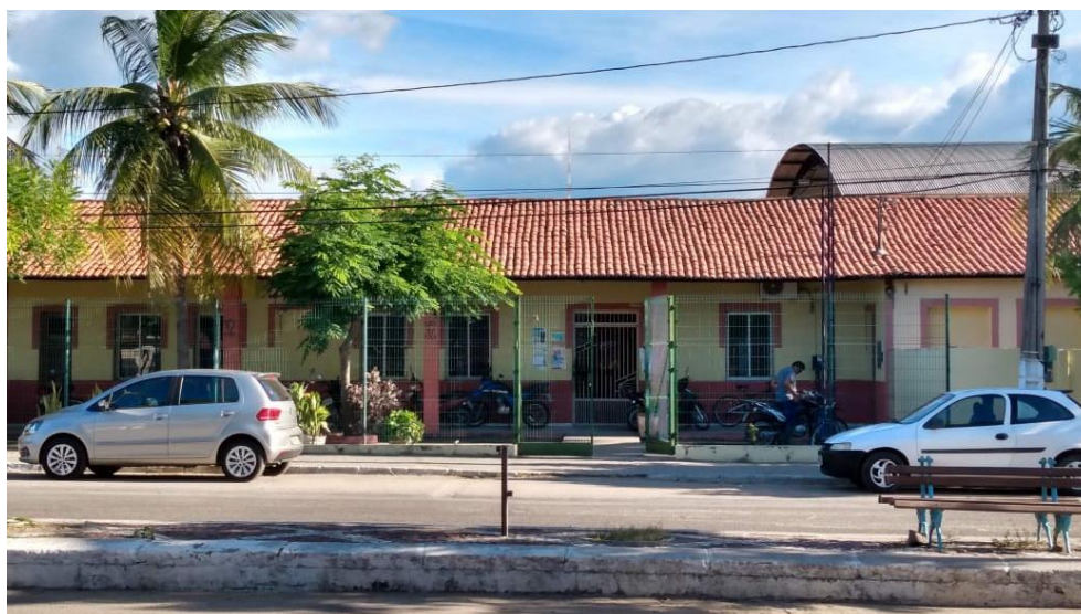
Figura 5 – Fachada da EEM de Amontada
