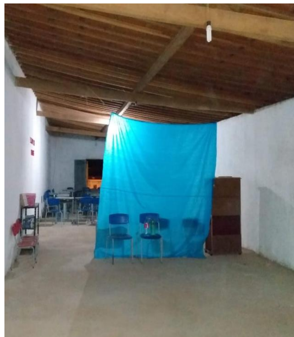
Figura 13 – Divisória improvisada das salas de aula
