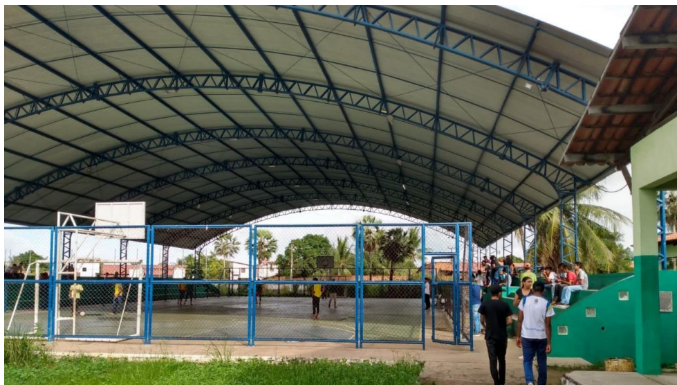
Figura 26 – Quadra coberta da EEM Waldemar Alcântara
