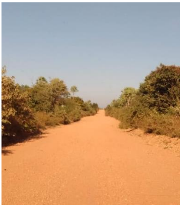
Figura 14 – Trecho da estrada para os distritos de Timonha, Adrianópolis e Ibuguaçu
