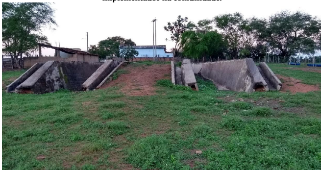
Figura 18 – Assentamento Lameirão – Silo de alvenaria de um dos projetos coletivos implementados na comunidade.
