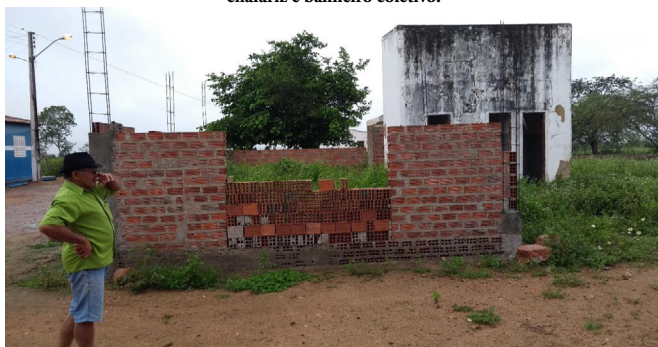
Figura 6 – Assentamento Peba – Construção de igreja no local onde existiam o chafariz e banheiro coletivo.
