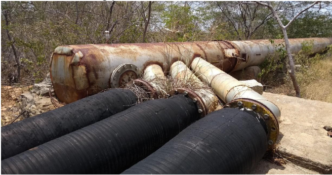
Figura 16 – Assentamento Lameirão - Estrutura de captação de água para fins de irrigação em uma fazenda confrontante.
