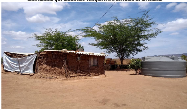
Figura 31 - Assentamento Olga Benário – Moradia de barro com cisterna de PVC, de uma família que ainda não conquistou a moradia de alvenaria.
