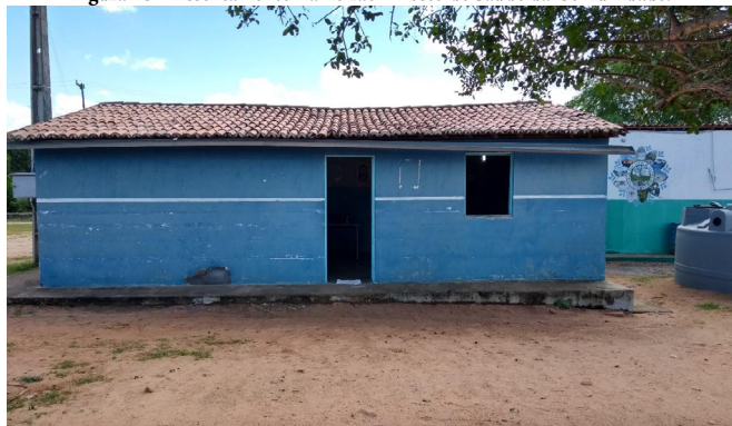
Figura 28 – Assentamento Lameirão – Posto de Saúde da Comunidade.
