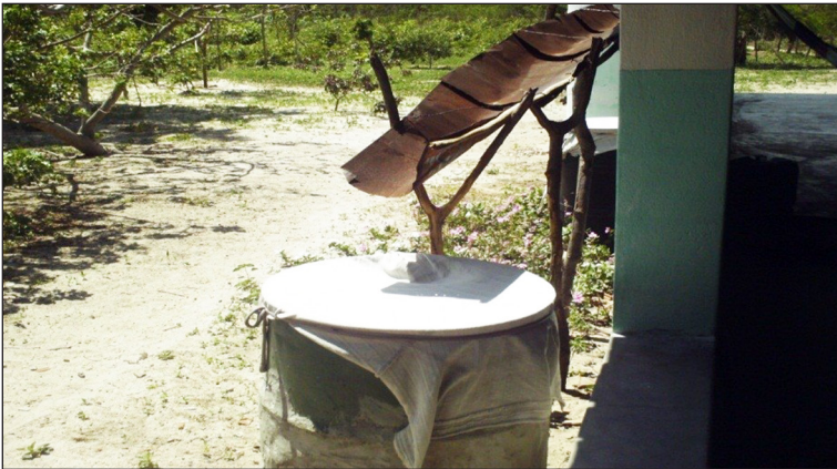
Imagem 33 – Calha instalada ao lado do telhado da casa de S. Carlito e D. Vicência
